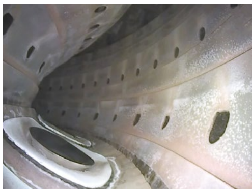
Câmara de combustão
